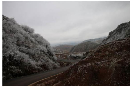
經過修繕的入村道路
